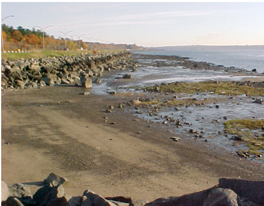
Site du projet dans son état actuel
